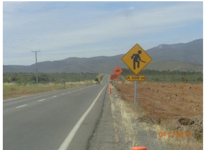
Trabajos escarpe calzada nueva.
