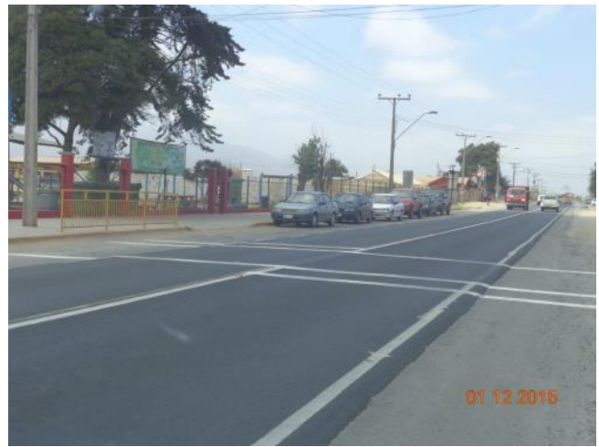
Trabajos de demarcación.
