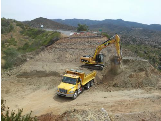
Trabajos excavación Enlace el Totoral.
