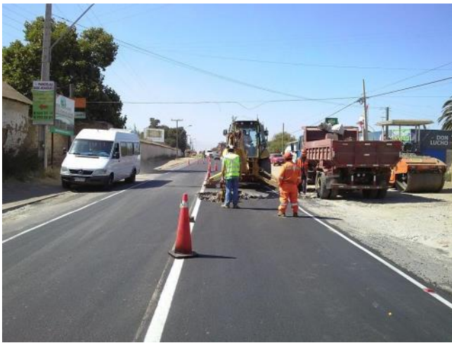
trabajos de pavimentación.
