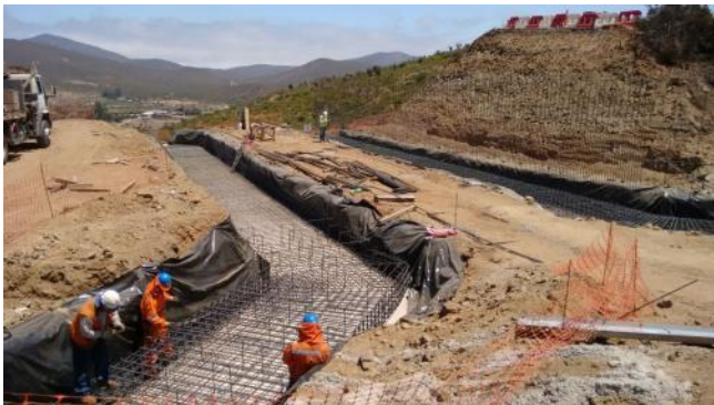
Trabajos Enlace el Totoral.
