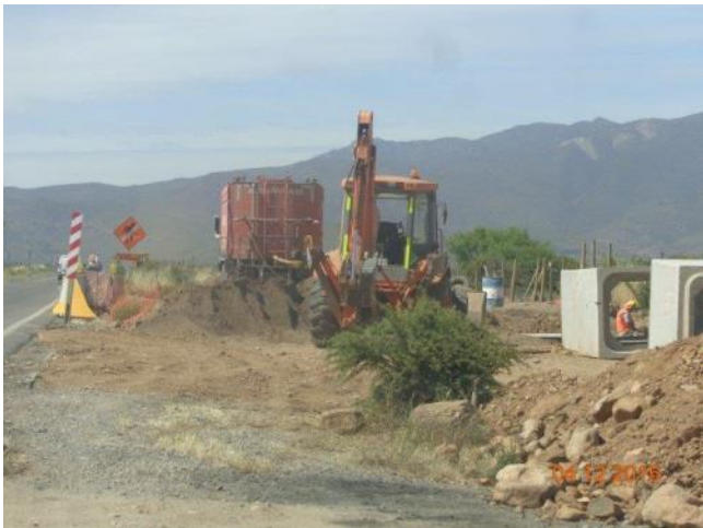
Trabajos relleno OA.
