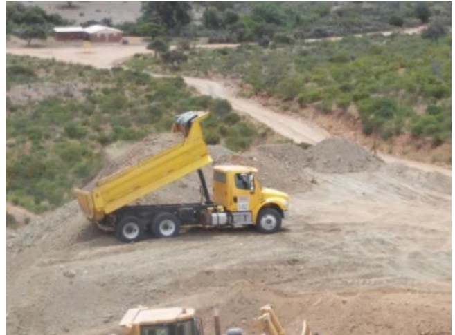
Trabajos excavación Enlace el Totoral.
