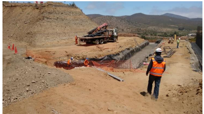
Trabajos Enlace el Totoral.
